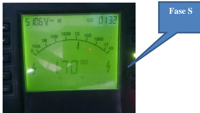
Gambar. 4 Megger Test Phase S
