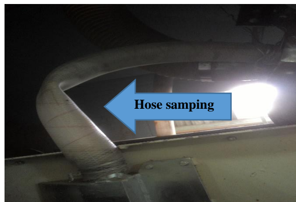
Gambar 3.2 permukaan hose menyempit
