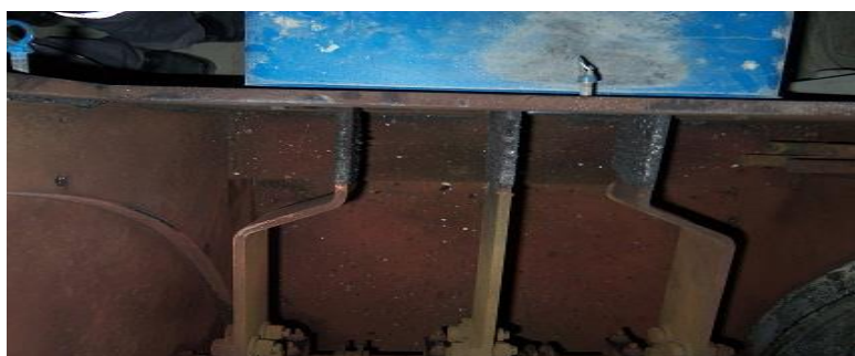
Gambar.1 Busbar yang Melting
