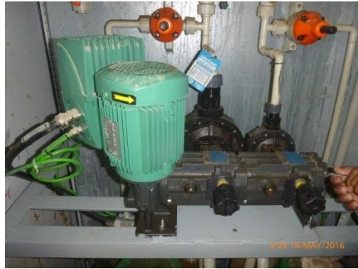
Gambar.9 Base frame pompa setelah modifikasi
