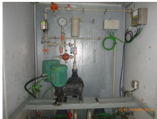
Gambar.10 Pump circuit setelah modifikasi
