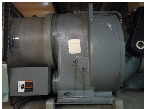
Gambar 1.2 Kompresor sentrifugal pada chiller water cooled
