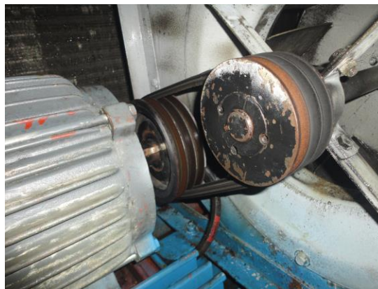
Gambar 1. Kerusakan V-belt pada centrifugal fan
