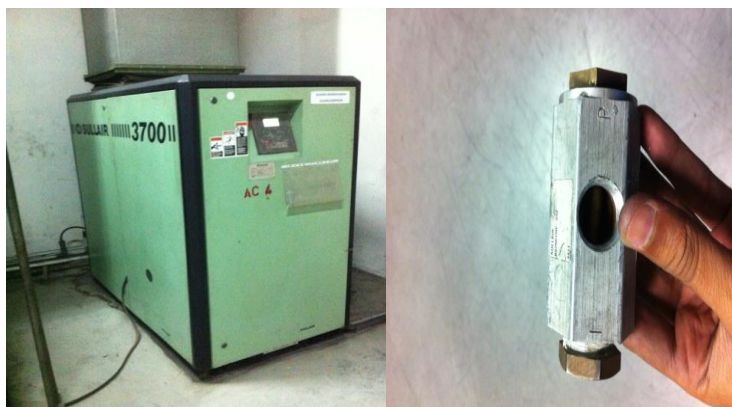
Gambar.2 Kompresor Sekrup Sullair WS3700 dan Blowdown Valve
