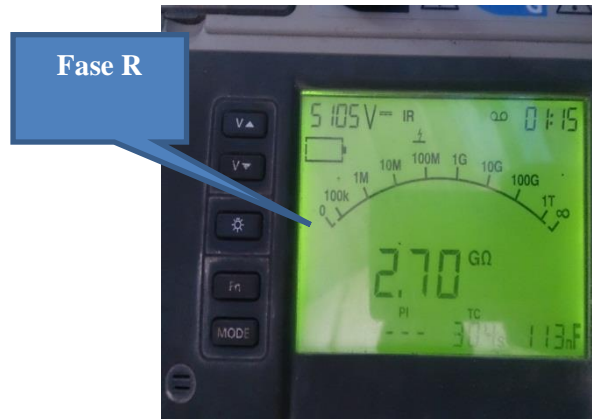
Gambar. 3 Megger Test Phase R
